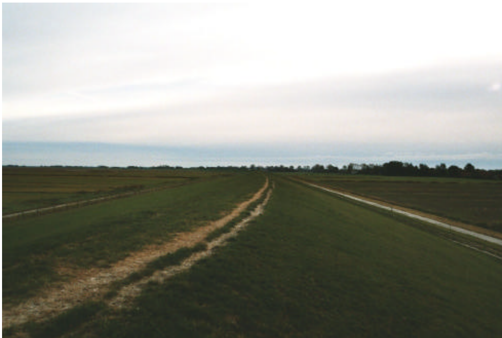
Abb. 26: Deich zwischen Vareler Hafen und Wapeler Siel, Blickrichtung Südosten. Rechts Ackerflächen, links Deichvorland
